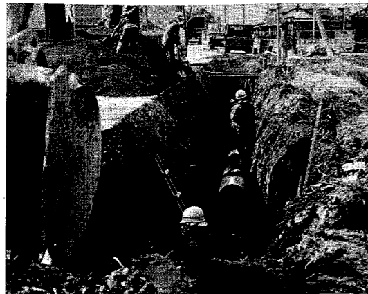
▲ 幹線パイプライン工事の進むかん排事業
