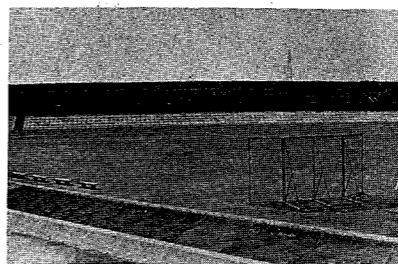
▲オープンした八幡運動場
