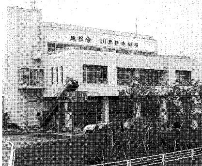
川島排水機場
