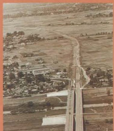
国道254号バイパス建設工事。(落合橋上空から)
