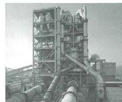
焼却灰のセメント処理施設
