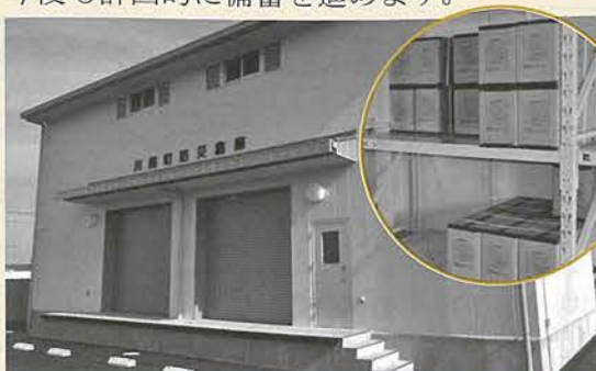
▲完成した防災倉庫
